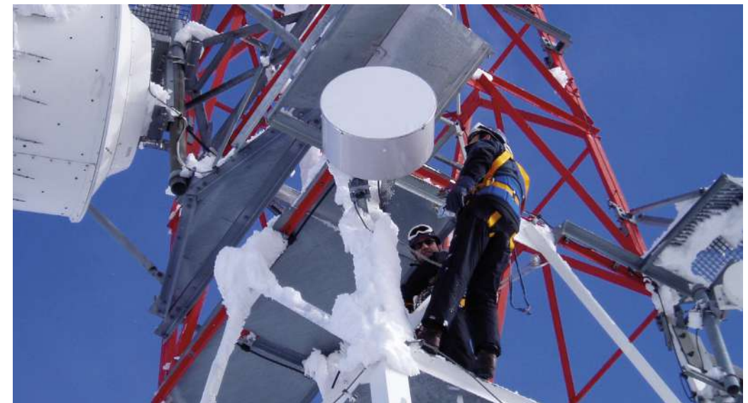
2006. Operarios de Telefónica instalan un radio enlace de emergencias tras una incidencia que dejó incomunicada a la localidad de Sabiñánigo en Huesca.
